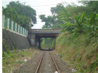
Terowongan Paledang sebelum pembangunan jalur ganda Bogor-Cicurug (Dokumentasi REDigest)
